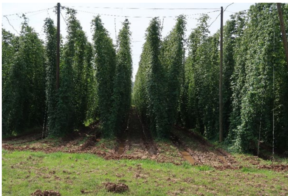
Obr. 62. Umístění kapkovacího potrubí na stropě chmelnicové konstrukce, Účelové hospodářství Stekník, CHI Žatec.
